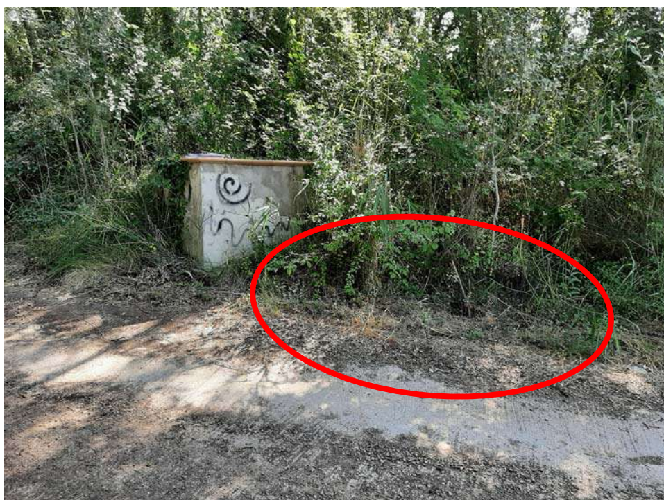
12 Vista general de l'arqueta de protecció de la captació del pou 2, zona prevista per la ubicació de l'arqueta semisoterrada del comptador de control de cabals del pou (cercle vermell).
