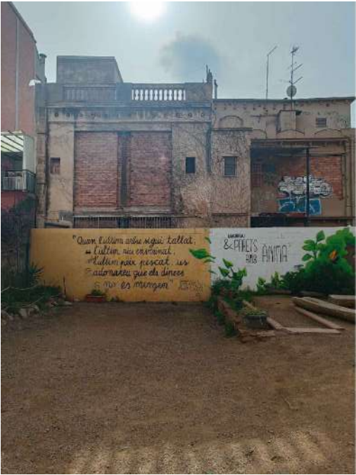
F06 Façana darrera caseta nº 17
