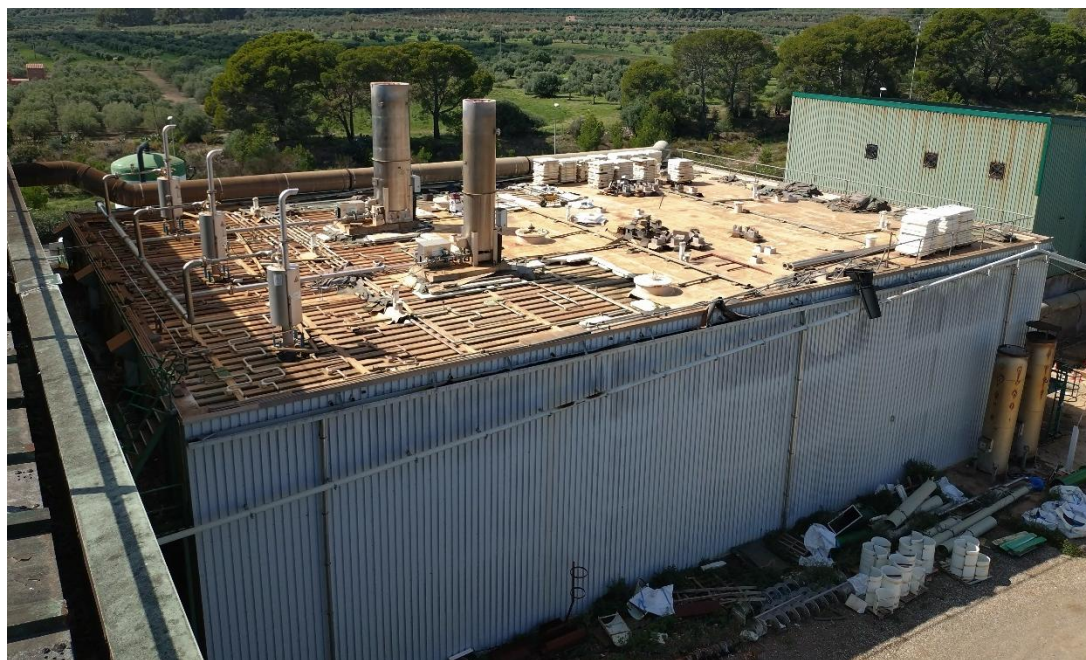
Imagen del estado actual de la cubierta.
