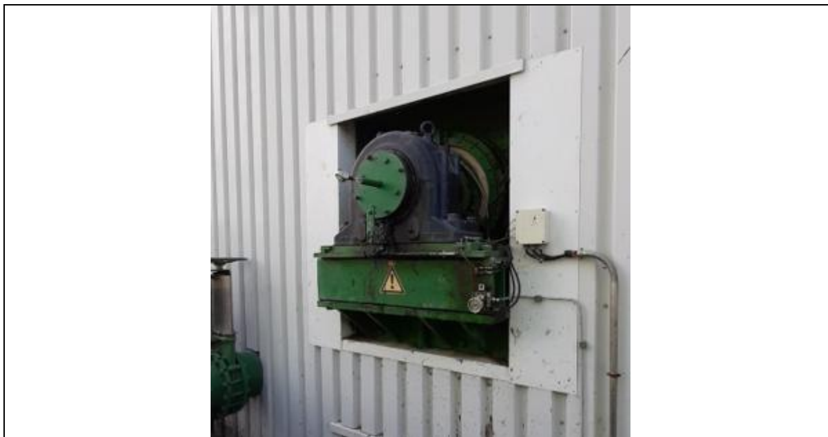
Vista junta lado salida material.
