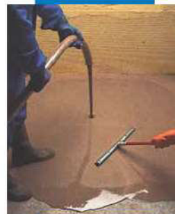
Aplicación de Ultraplan con bomba y posterior rastrillado
