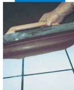
Extensión con llana metálica sobre pavimento existente de cerámica, previa aplicación de Mapeprim SP
