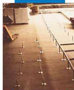
Solera nivelada con Ultraplan para la puesta en obra de pavimentos sobre elevados
