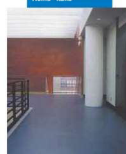
Ejemplo de instalación de linóleo realizada sobre nivelación de Ultraplan - Conservatorio de Monzón - España
