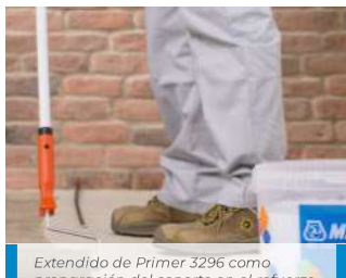
Extensión de Primer 3296 como preparación del soporte en el refuerzo de forjados de bovedilla cerámica y vigueta de hormigón con Planitop HPC Floor
