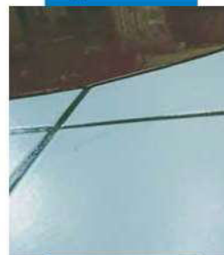
Ejemplo de aplicación de Ultraplan sobre pavimento de cerámica existente, previa aplicación de Mapeprim SP
