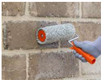
Aplicación de Primer 3296 a rodillo sobre albañilería de tufo
