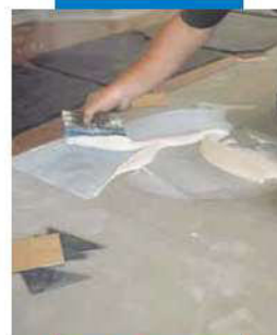
Ejemplo de colocación de PVC sobre nivelación de Ultraplan - Milán - Italia
