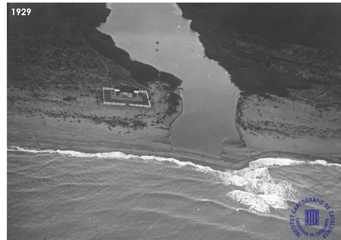
Figura 8.- Morfologia primigènia de la zona de projecte abans de la majoria de les actuacions antròpiques: Desembocadura del Remolar l'any 1929. Font: Marciglob a partir de material gràfic de l'ICGC
