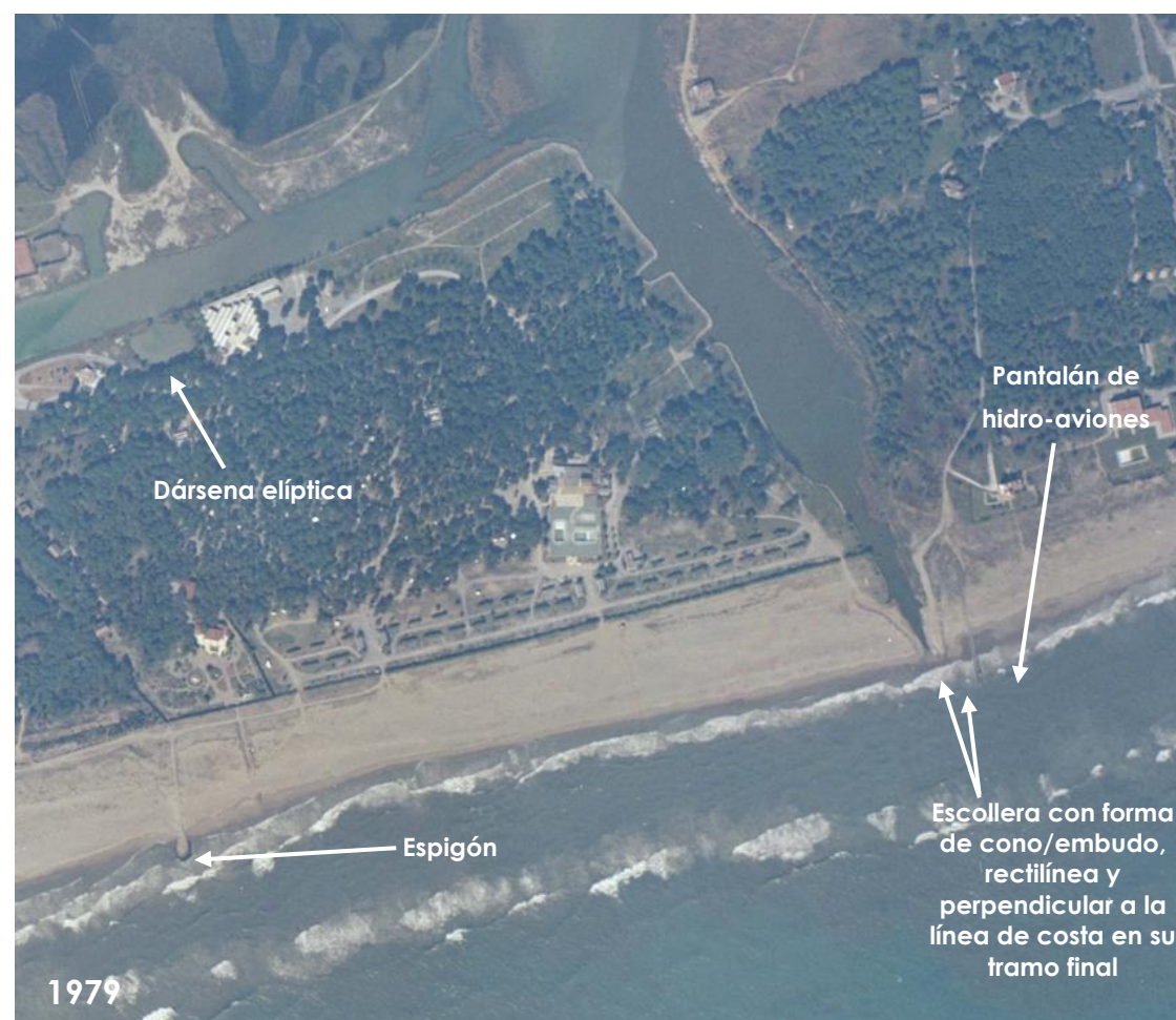
Figura 64.- Vistas aéreas cenitales de los espacios del estanque del Remolador y de la marisma de las Filipinas. Se aprecia la presencia de la dársena de planta elíptica, así como la protección de escollera de la salida del estanque del Remolador con forma de cono y que en su último tramo es rectilínea y aproximadamente perpendicular a la línea de costa. Fuente: SACE e ICGC.
