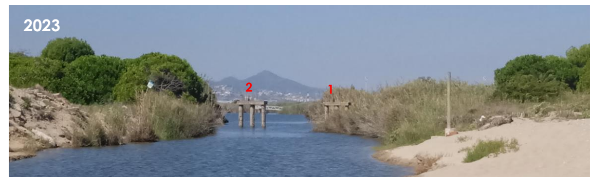
Figura 49.- Desembocadura del Remolar. Pasarela del embarcadero apoyada sobre pilotes en los años 60 del siglo XX (arriba, en rojo), y sus restos (pilotes) en 2011 (arriba, derecha) y 2023 (abajo). Fuente: Marciglob a partir de material gráfico del ICGC (arriba) y Marciglob (abajo).
