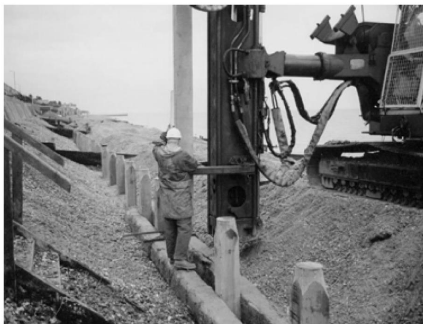
Figura 4.- Exemple de col·locació de pantalla i pilots mitjançant clava d'aquests últims
