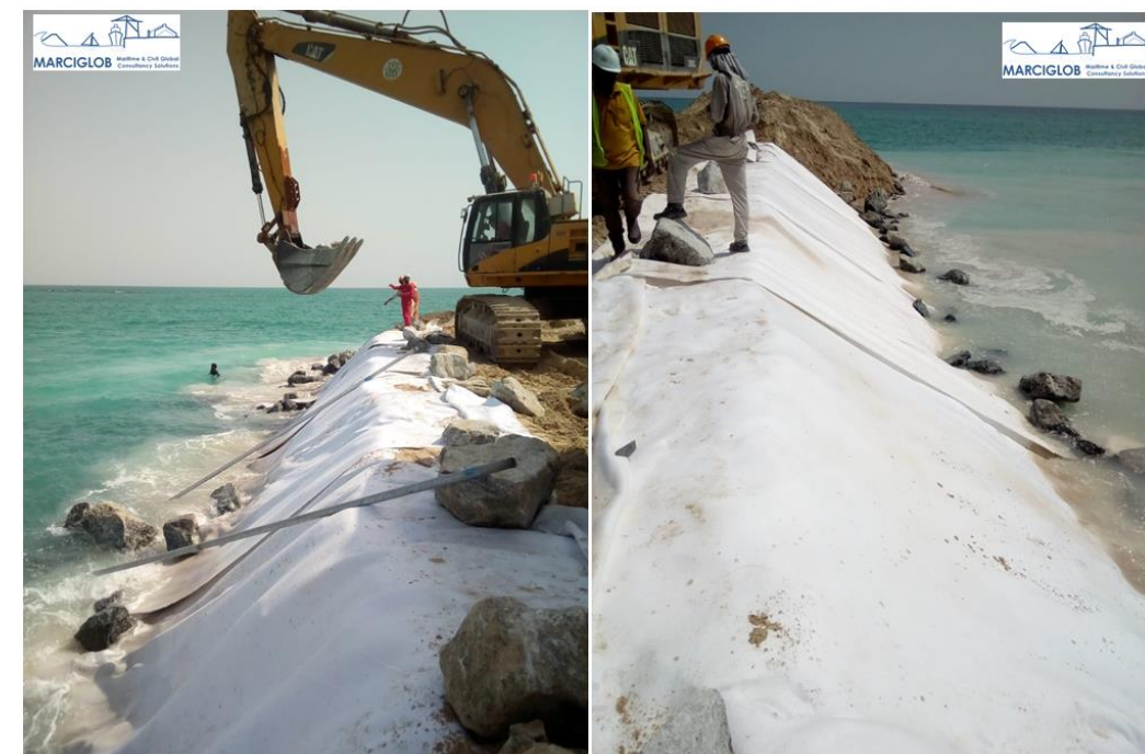
Figura 2.- Col·locació de filtre de geotèxtil sobre escullera sense classificar en un espigó en aigües someres. Font: Marciglob.
