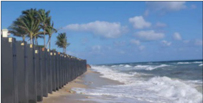
EXEMPLES DE LA UTILITZACIÓ DE PALPLANXES EN LA PROTECCIÓ CONTRA INUNDACIONS I ULTRAPASSAMENTS.
