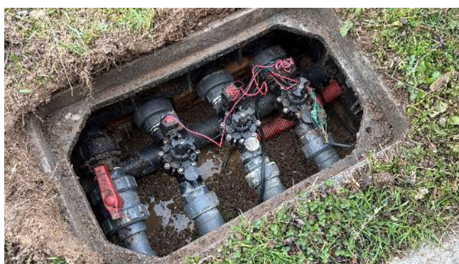
Imatges 6, 7 i 8: Aspersors, electrovàlvules i programador
