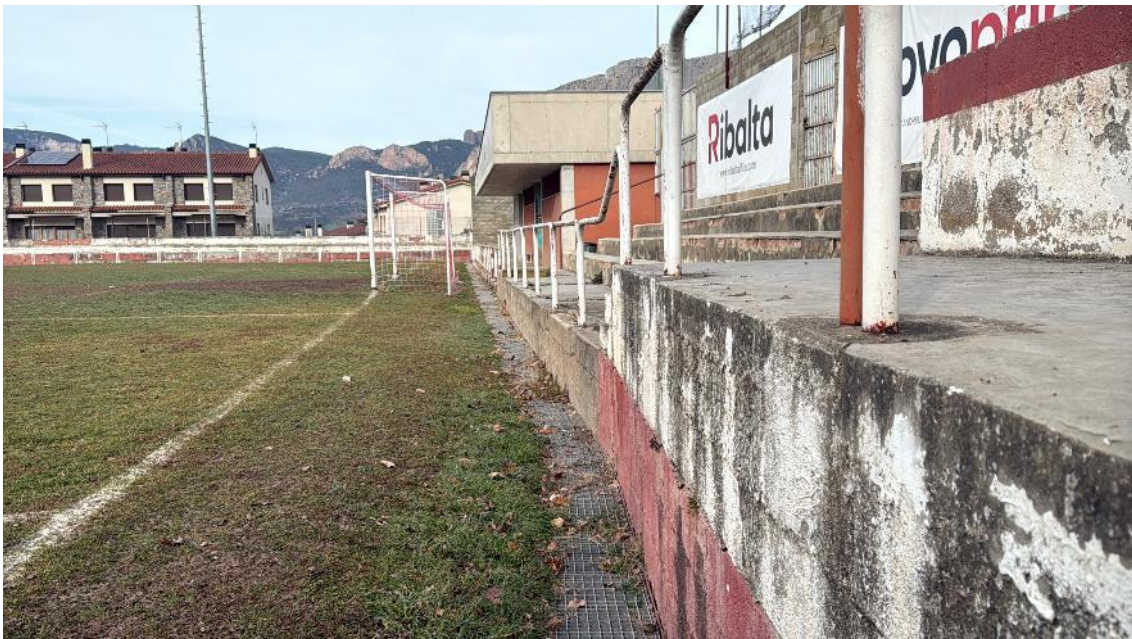
Imatges 9, 10, 11: Cunetes i reixes interceptores existents
