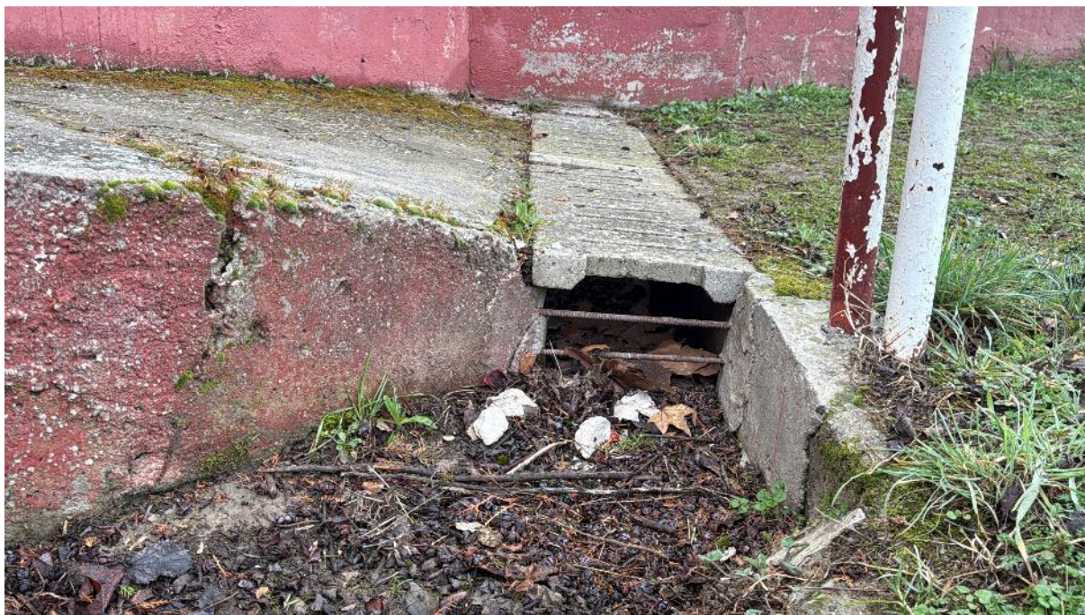
Imatge 18. Sistema d'evacuació d'aigua
