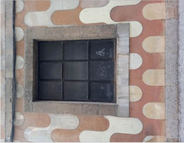
FOTOGRAFIA 13 (FINESTRA QUE SE SUBSTITUIRÀ PER UNA REIXA DE VENTILACIÓ PER LA UNITAT EXTERIOR DE CLIMATITZACIÓ)
