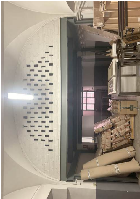
Fotografia des de Vestibul (estat actual)
