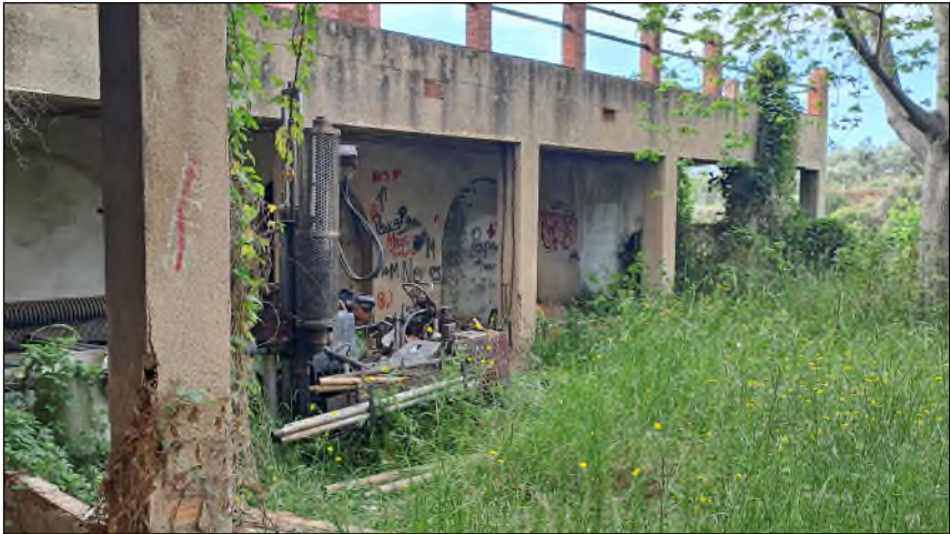
Sondeig S-1. Emplaçament
