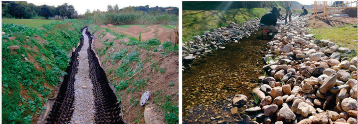
Figura 22 Canals impermeabilitzats
