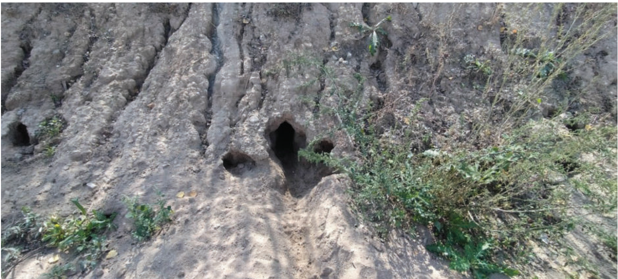
Figura 13 Cavitats existents als talussos de la bassa
