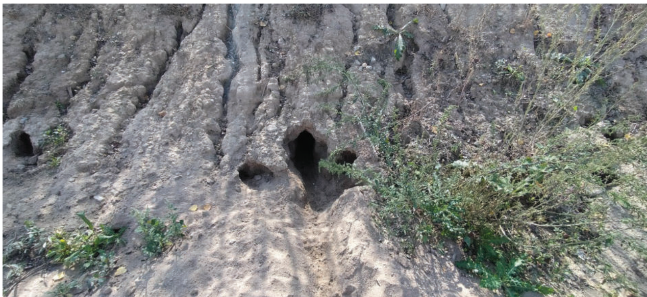
Figura 14 Cavitats presents al peu del talús de la bassa de laminació
