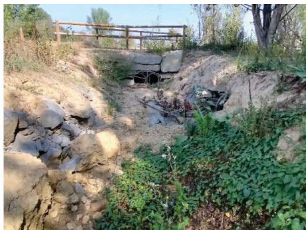
Figura 9 Processos erosius al llarg del canal
