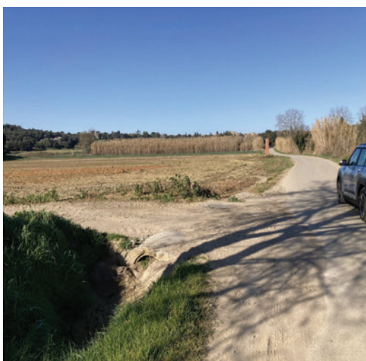
Diferents imatges del camí vell de Palau-Sator, on s'aprecien tubs plens de terra i cunetes colmatades
