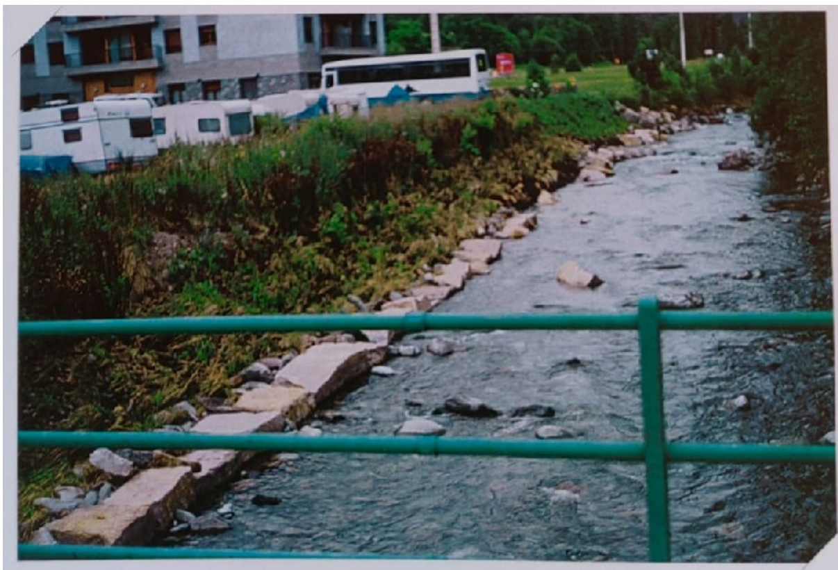
Fotografia històrica, prèvia a la rehabilitació de l'any 2002
