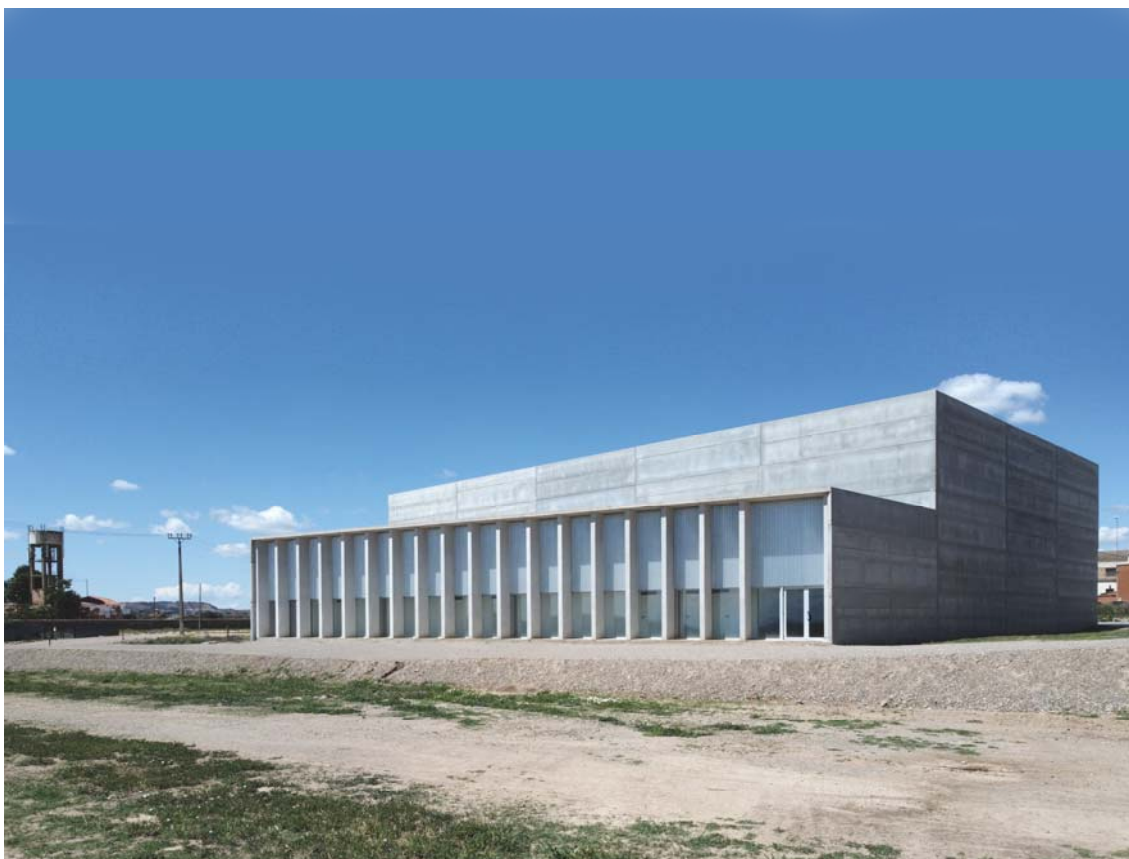
Fotografia emplaçament. FASE -3
