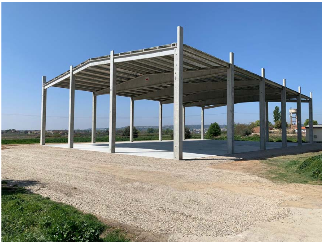
Fotografia emplaçament. FASE -1
