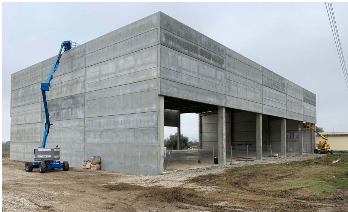
Fotografia emplaçament. FASE -2
