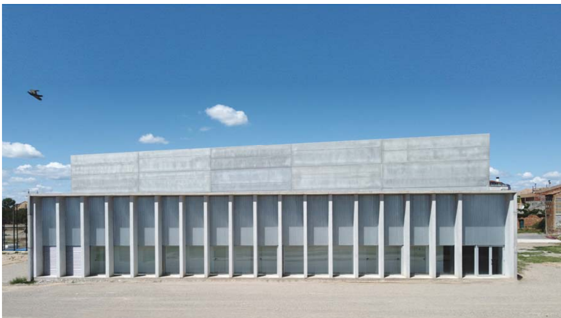
Fotografia emplaçament. FASE -3
