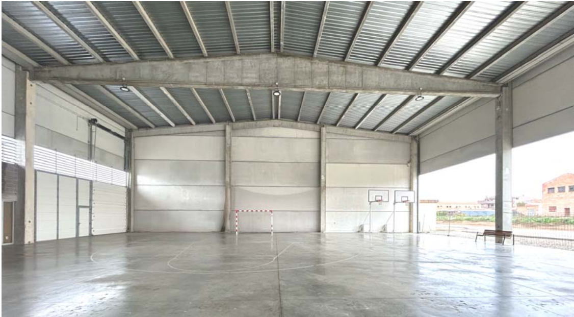
Estat actual de la zona d'actuació
