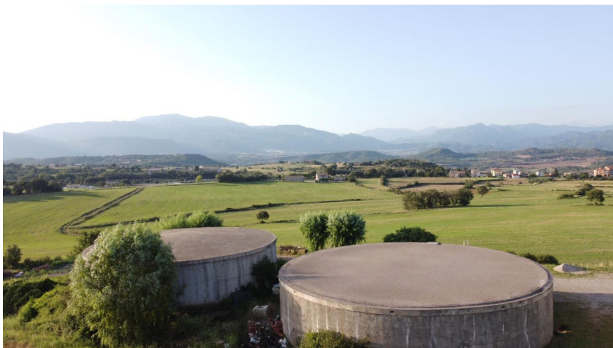
Fig. 2 Vista detall de les cobertes dels dipòsits
