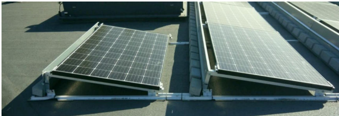
Fig. 4 Exemple de fixació de l'estructura
