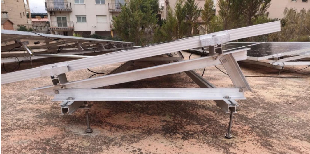
Fig. 7 Exemple de fixació de l'estructura
