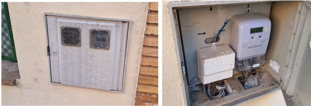
Imatge amb CGP, derivació individual i comptador
