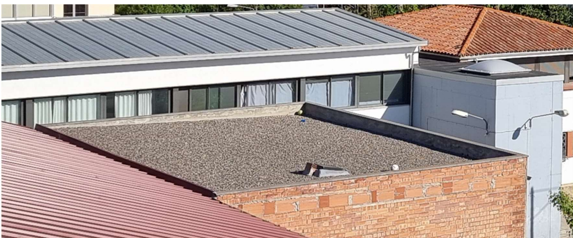
Imatge coberta plana edifici annex al gimnàs
