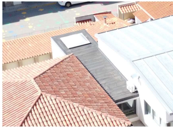
Imatge coberta plana entre edificis
