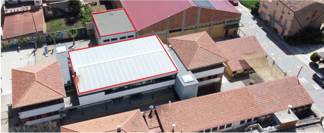
Imatge zona coberta a actuar realitzada des de l'oest
