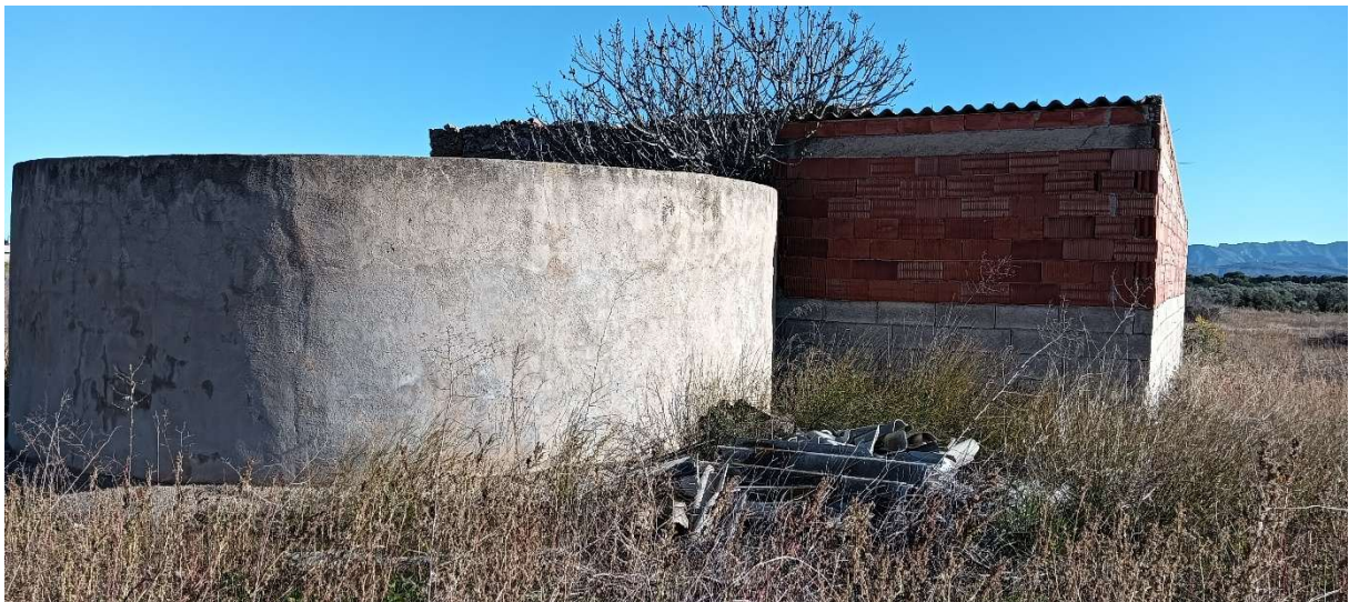
Fig. 13.- Edificació d'obra, amb presència d'uralita.
