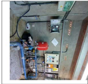
Foto3: Detalles de toma eléctrica y recorrido del cableado
