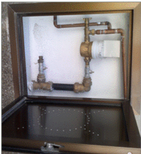
Exemples d'instal·lacions de comptador amb mòdul de telelectura incorporat
