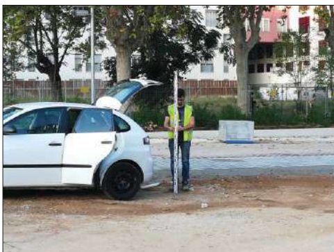
Fotografia 5. Presa de cotes topogràfiques relatives.
