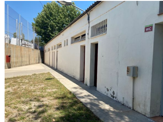
Façana principal (accessos als vestidors, als serveis higiènics destinats al públic assistent i a les zones d'emmagatzematge)
