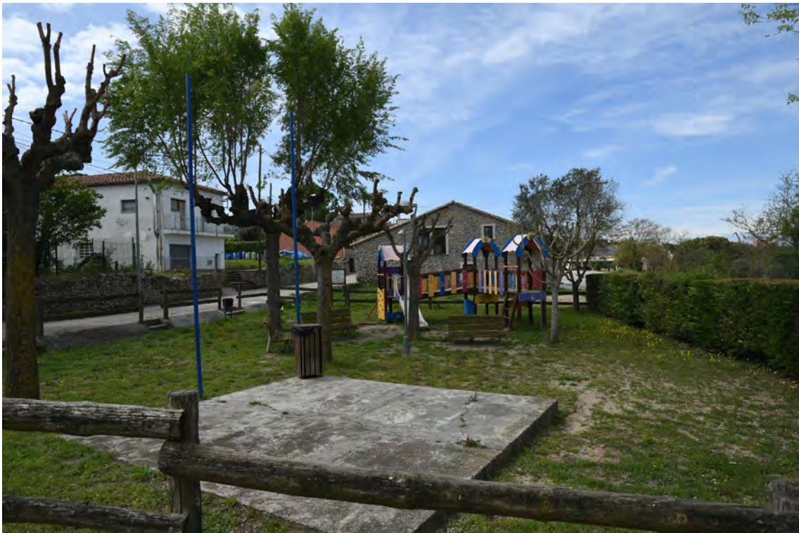
Llosa de formigó en la zona de jocs
