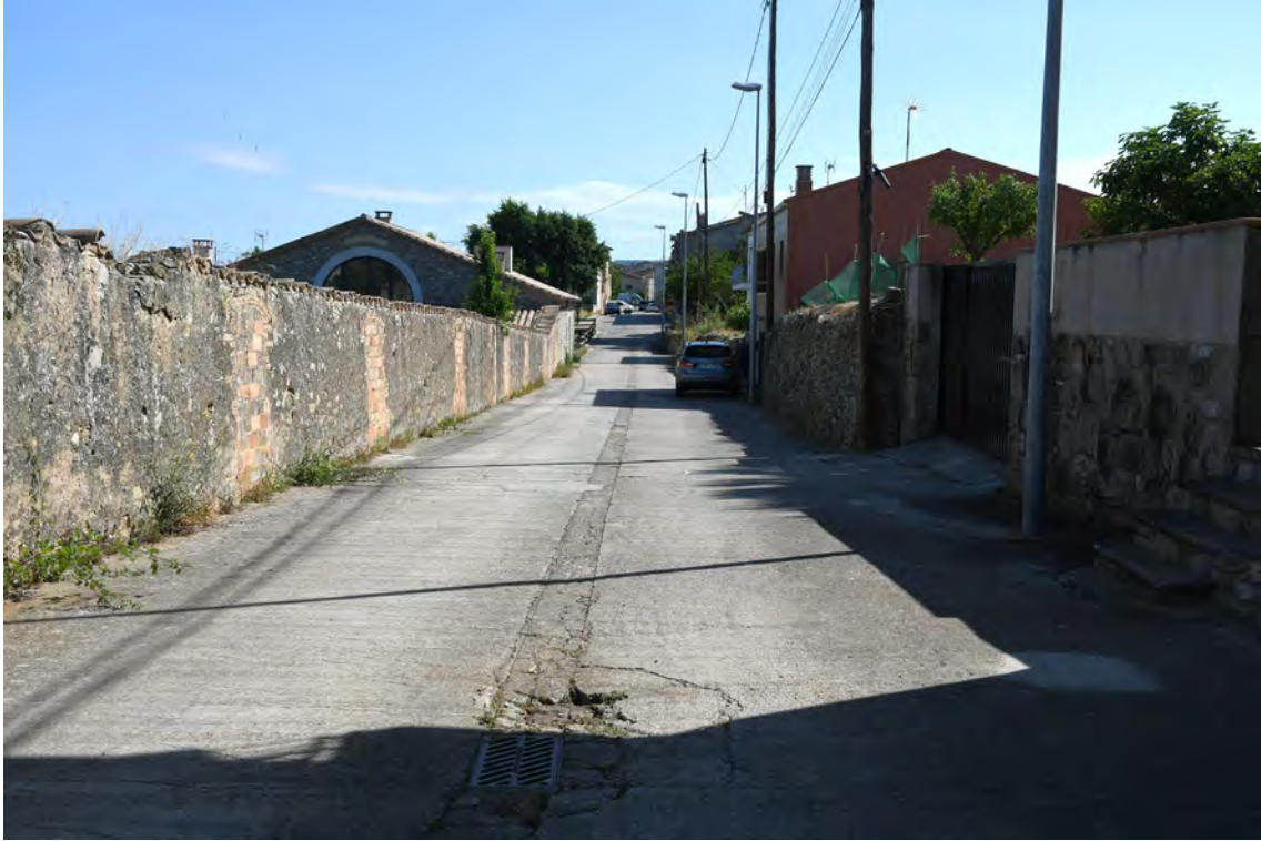
Paviment d de formigó trencat en la zona dels embornals.
