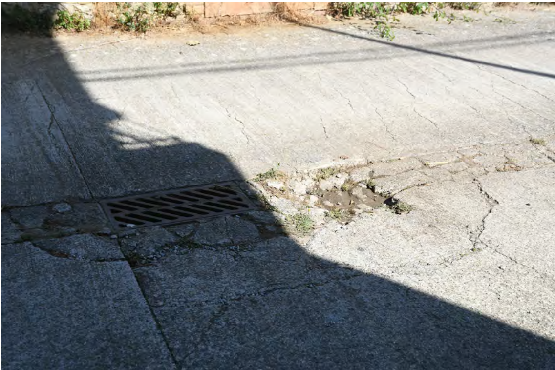
Paviment d de formigó trencat en la zona dels embornals.
