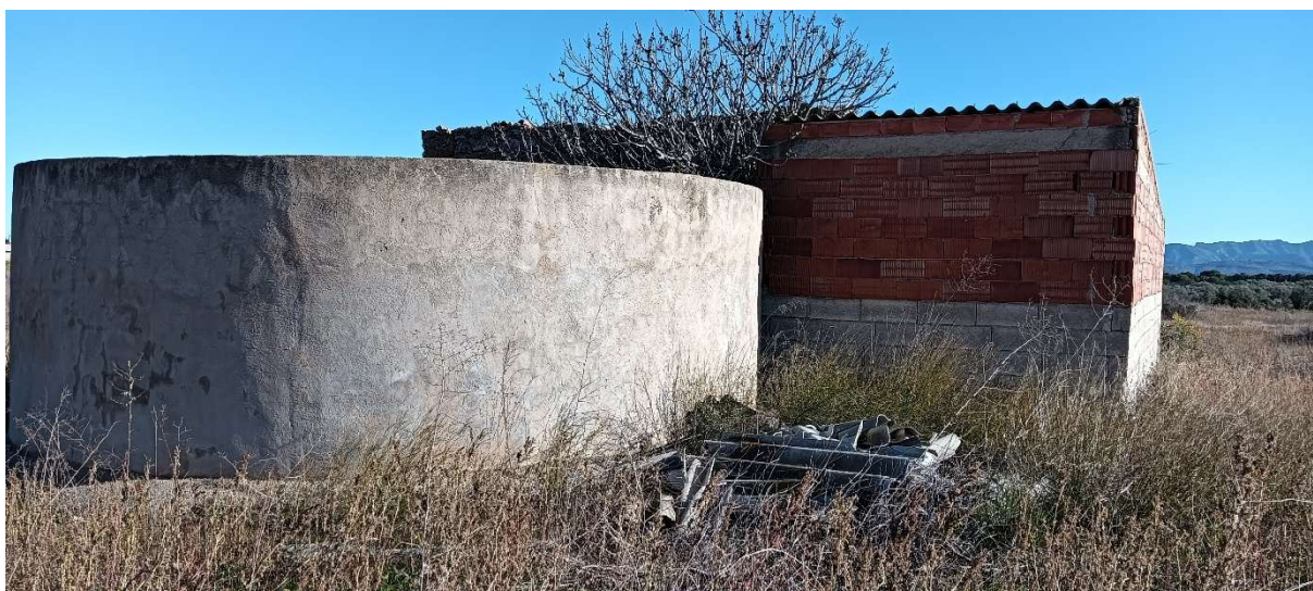
Fig. 13.- Edificació d'obra, amb presència d'uralita.
