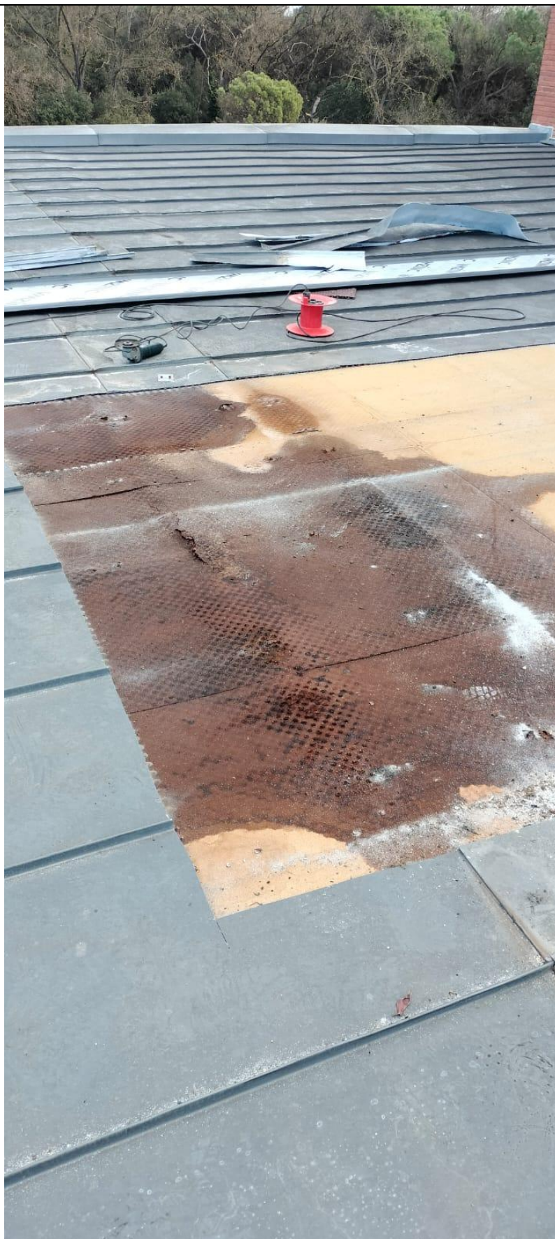
Estat de les diferents capes inferiors provocat pel trencament de la integritat
