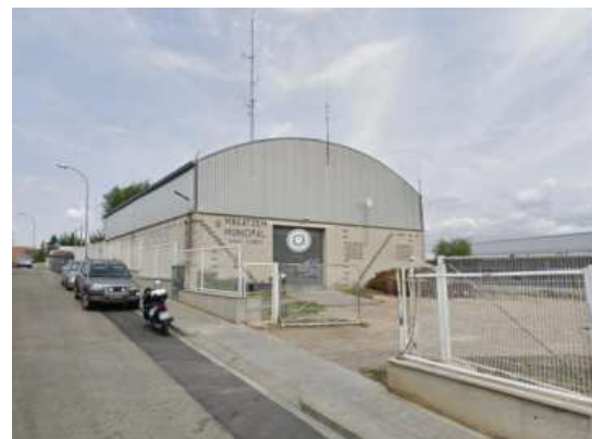
Figura 9. Ubicació nova antena concentradora de teletectura a la teulada del magatzem municipal del carrer de les escoles.
