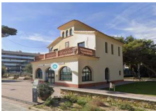
Figura 5. Ubicació de l'analitzador d'aigua del sector Port a l'interior de l'edifici del Patronat de Turisme.
