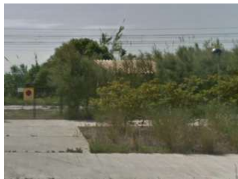
Figura 8. Ubicació nova antena concentradora de teletectura dins del tancat de l'EBAR de Torredembarra.
