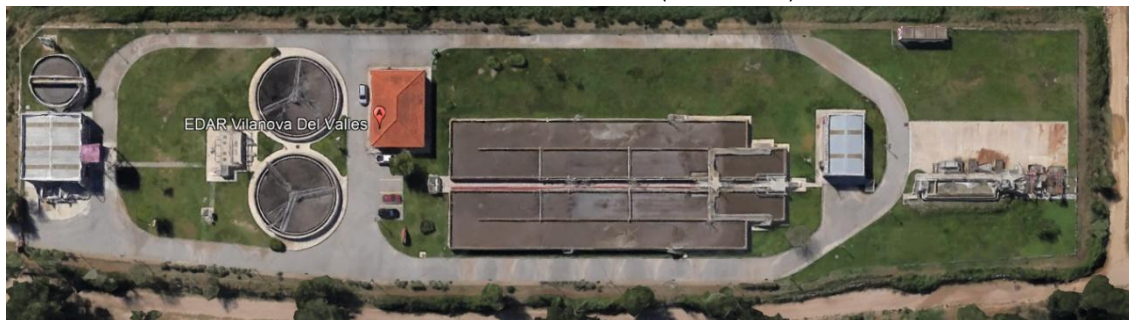
Vista aèria de l'EDAR Vilanova del Vallès
