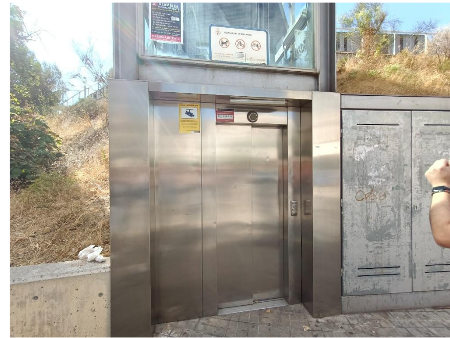
Imatge 2. Accés ascensor en nivell inferior (Carrer Vallcivera)
