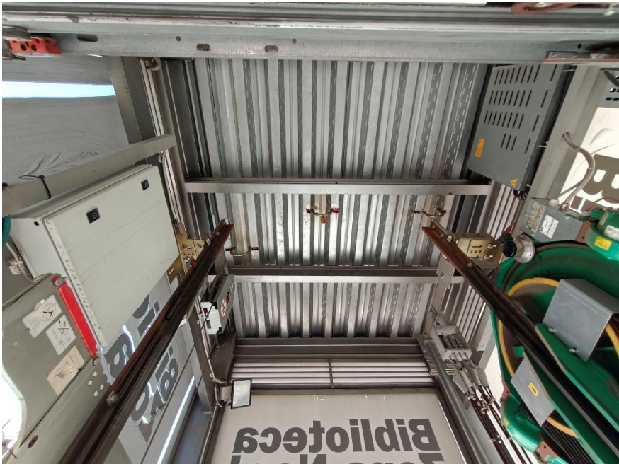
Imatge 15. Estructura i coberta vist des del interior
