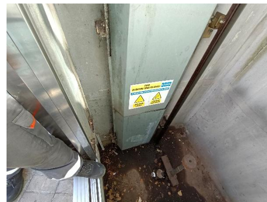
Imatge 5. Interior fossat ascensor
