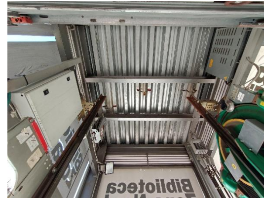
Imatge 5. Coberta vista des de l'interior
