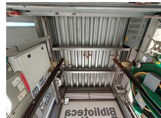
Imatge 6. Coberta vista des de l'interior
