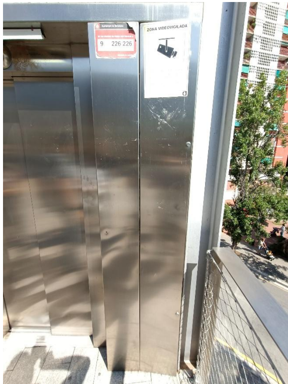
Imatge 12. Armari lateral exterior en nivell superior
