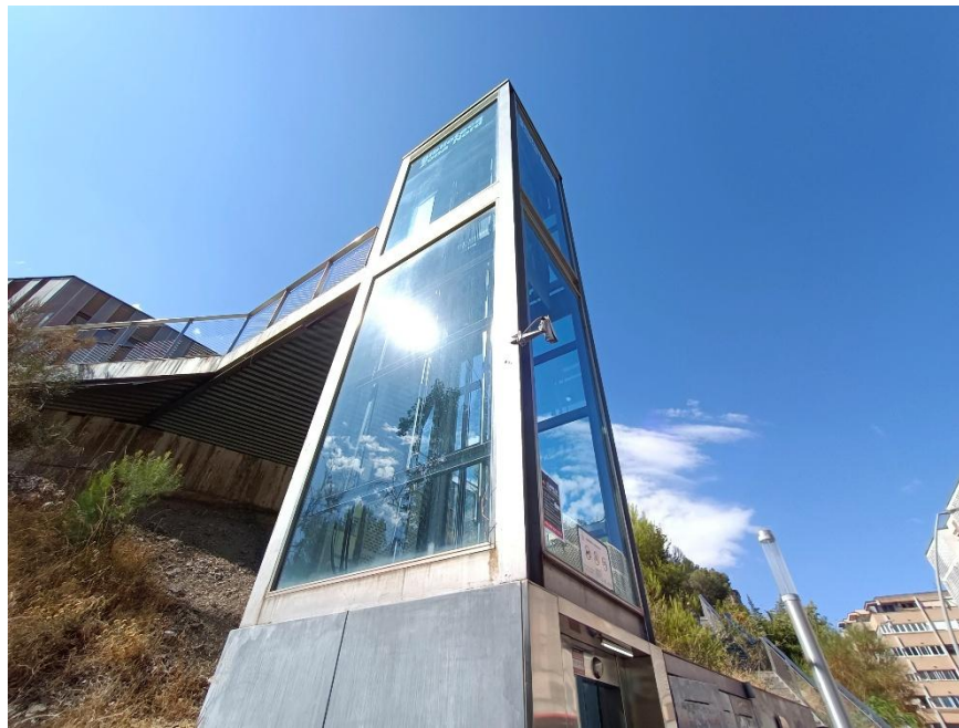
Imatge 1. Vista general ascensor existent
