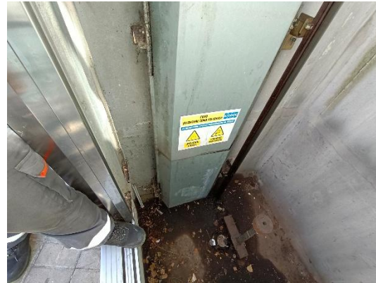
Imatge 4. Interior fossat ascensor
