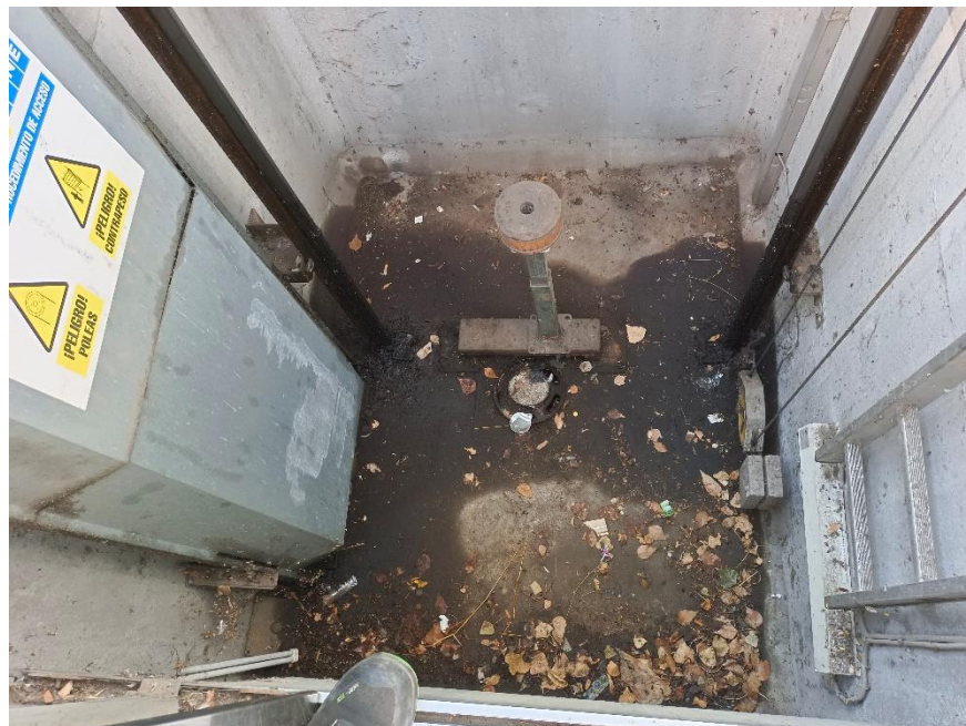
Imatge 4. Fossat ascensor existent
