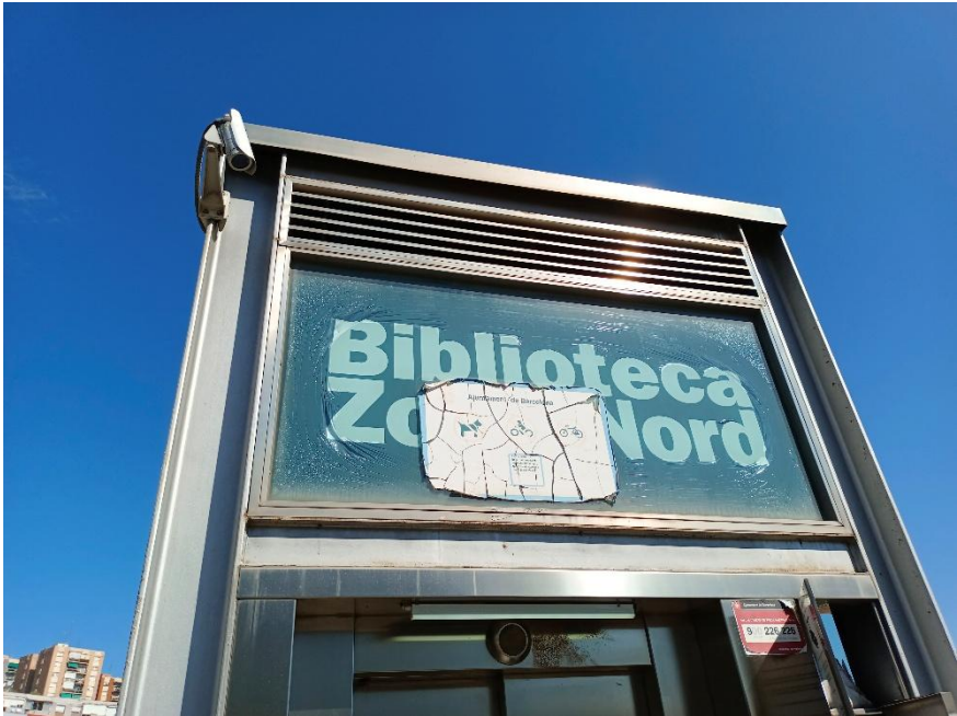
Imatge 14. Reixes de ventilació de lames en "Z" part superior edicle
