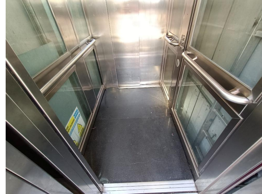
Imatge 10. Interior cabina ascensor
