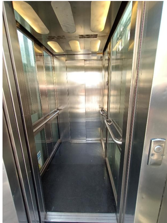
Imatge 8. Vista interior cabina ascensor
