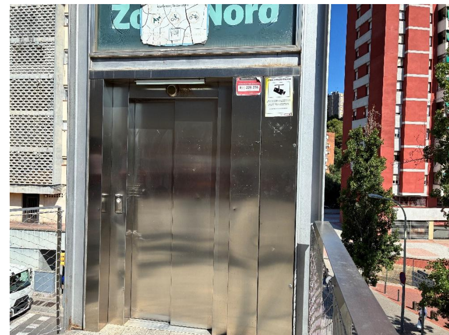
Imatge 3. Accés ascensor en nivell superior
