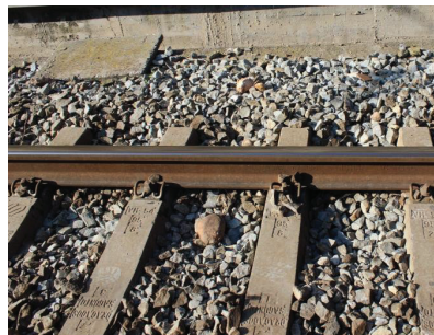
Foto nº3. Fragment de roca entre rails (any 2015).
