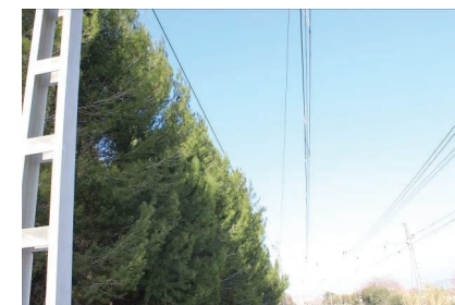
Foto n°2. Arbres propers a la catenària
