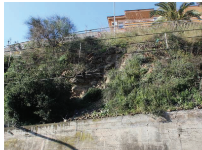
Foto nº1 i Foto nº2. Afloraments rocosos molt meteoritzats estabilitzats en l'any 2016.
