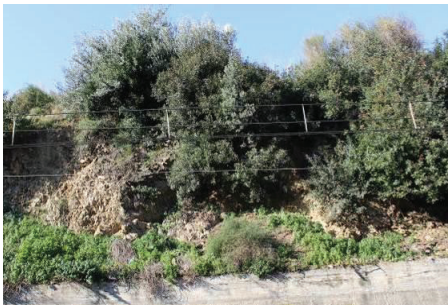
Foto nº1 i Foto nº2. Afloraments rocosos molt meteoritzats estabilitzats en l'any 2016.
