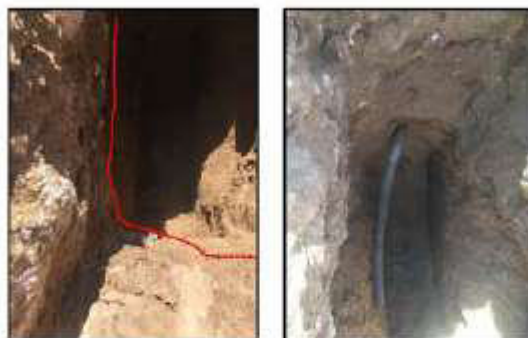
Fotografia 1 i Fotografia 2. Detall dels materials aflorants a la cala oberta, corresponent als materials de rebliment antròpic.
