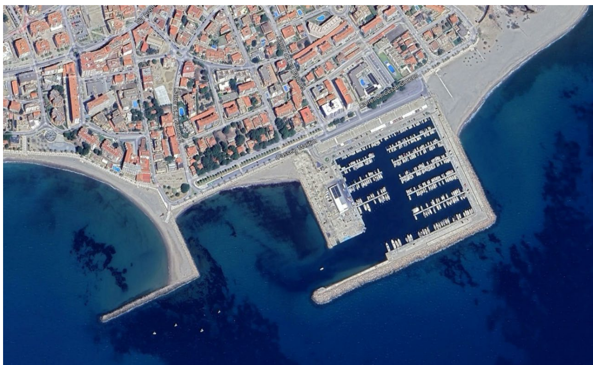
Figura 1. Vista aèria de les instal·lacions objecte d'estudi del port de l'Hospitalet de l'Infant.
