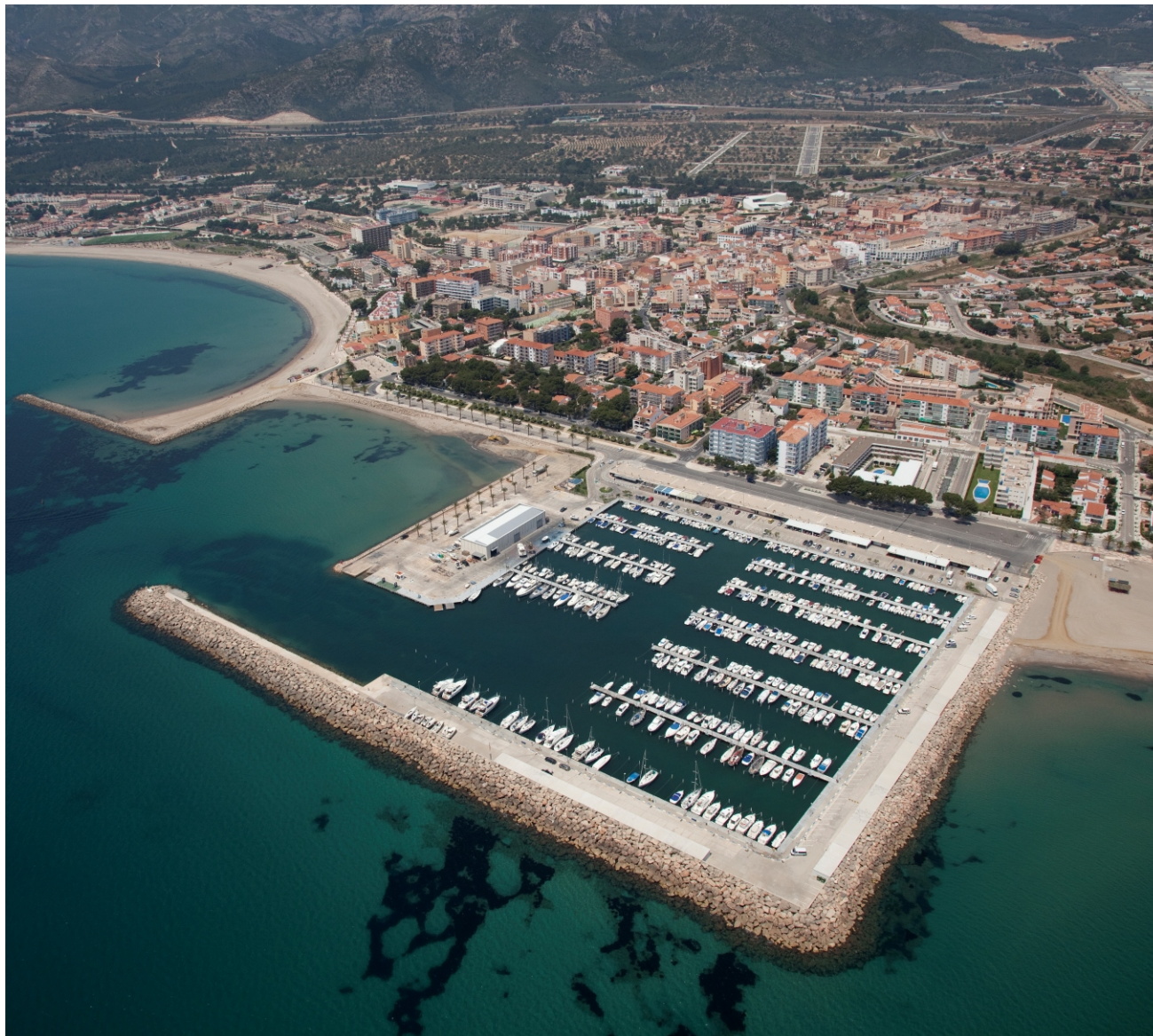
Vista aèria de l'estat actual del Port de l'Hospitalet de l'Infant
