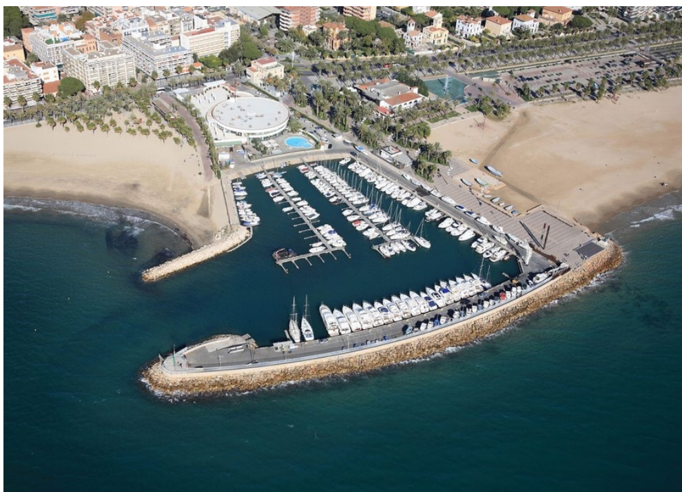
Figura 1. Vista aèria de les instal·lacions objecte d'estudi del port de Salou.
