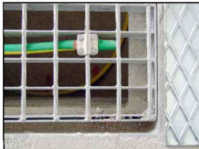
UNIÓ DE FERRAMENTA I MALLA AMB SOLDADURA IMATGE D'EXEMPLE
