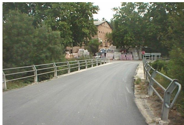
Plataforma (Vista des estrep 1)
