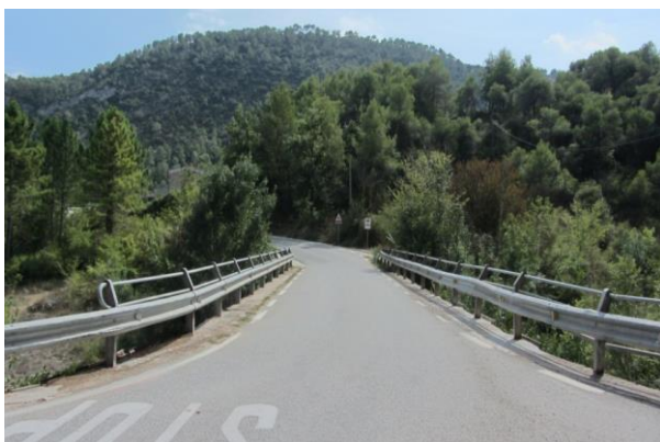
Plataforma (Vista des estrep 2)
