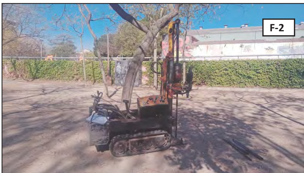
Fotografies 1 i 2: Vista de l'emplaçament de la màquina per a la realització dels assaigs de penetració dinàmica DPSH, P-1 i P-2, respectivament.
