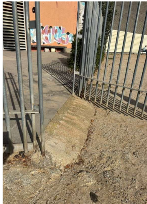
Detall rampa accés
