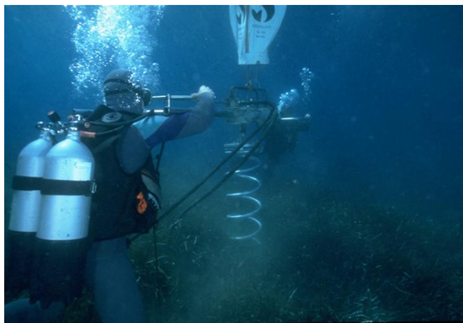
Figura 8 | Instal·lació d'un sistema de fixació tipus cargol espiral (Francour et al., 2006: "Guia de gestió per a les àrees marines protegides de la Mediterrània" 4 ).
