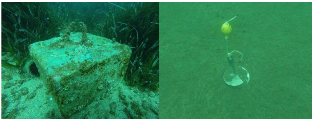
Figura 12 | Bloc de formigó amb l'anella trencada (esquerra; Jordi Sànchez-SUBMON) i cargol helicoidal desenterrat d'un fons sorrenc (dreta; Andreu Dalmau-SUBMON).
