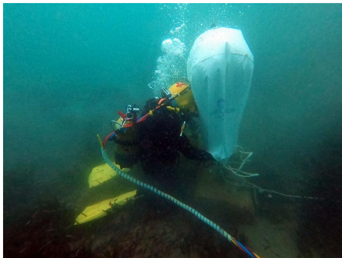
Figura 5 | Moviment d'un bloc de formigó fent servir un globus elevador (Andreu Dalmau – SUBMON).
