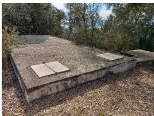
Exterior del Dipòsit de Can Piu
