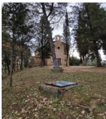
Exterior Dipòsit Ermita Sant Roc
