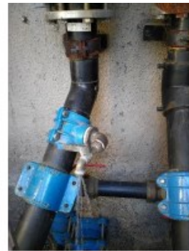
Exterior dipòsit Can Regàs; Comptadors de sortida; Punt de mostreig del dipòsit
