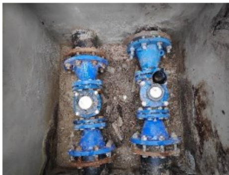
Exterior dipòsit Can Regàs; Comptadors de sortida; Punt de mostreig del dipòsit
