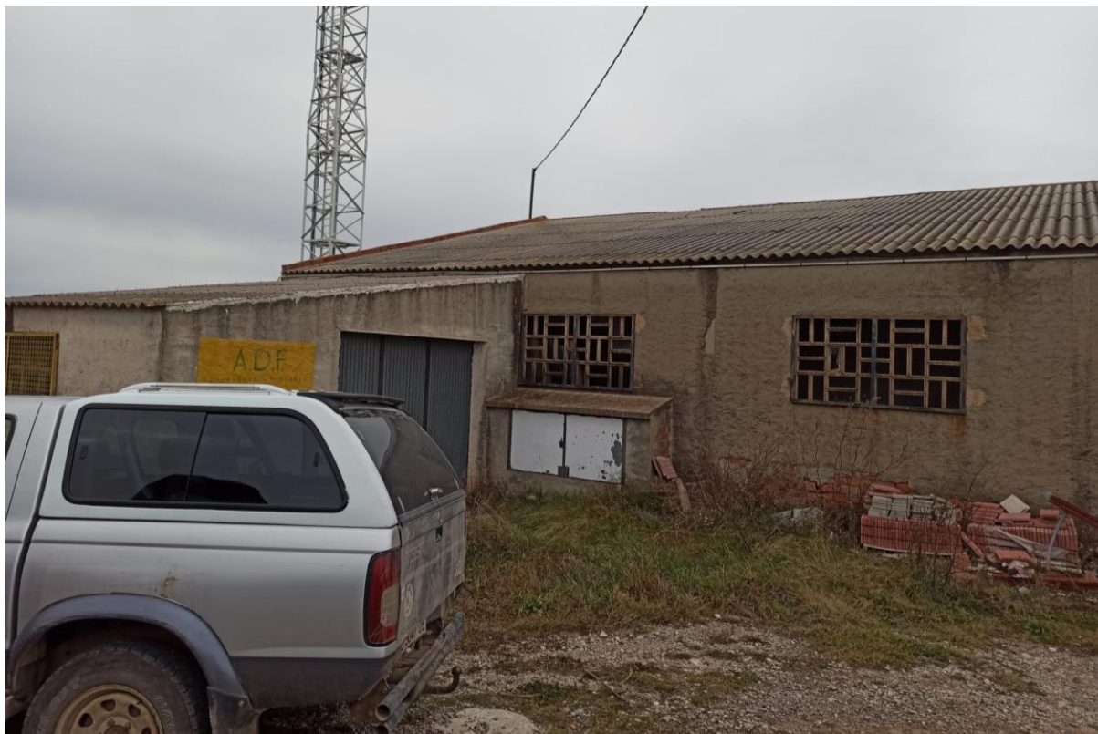
Imatge 1 Exterior Dipòsit d'aigua
