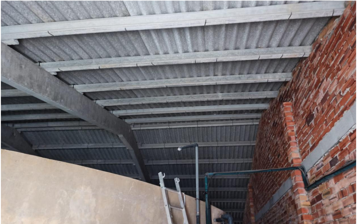
Imatge 3 Interior Dipòsit d'aigua
