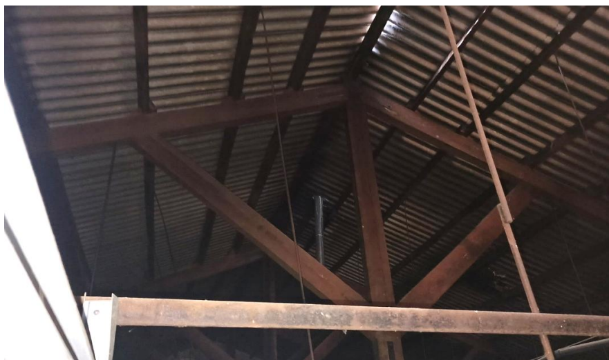
Imatge 7 Vista de l'estructura i la coberta de la Sala de Foment.
