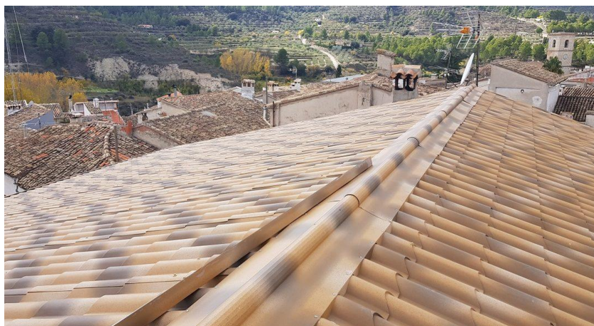
Imatge 11 Panell sandvitx envellit
