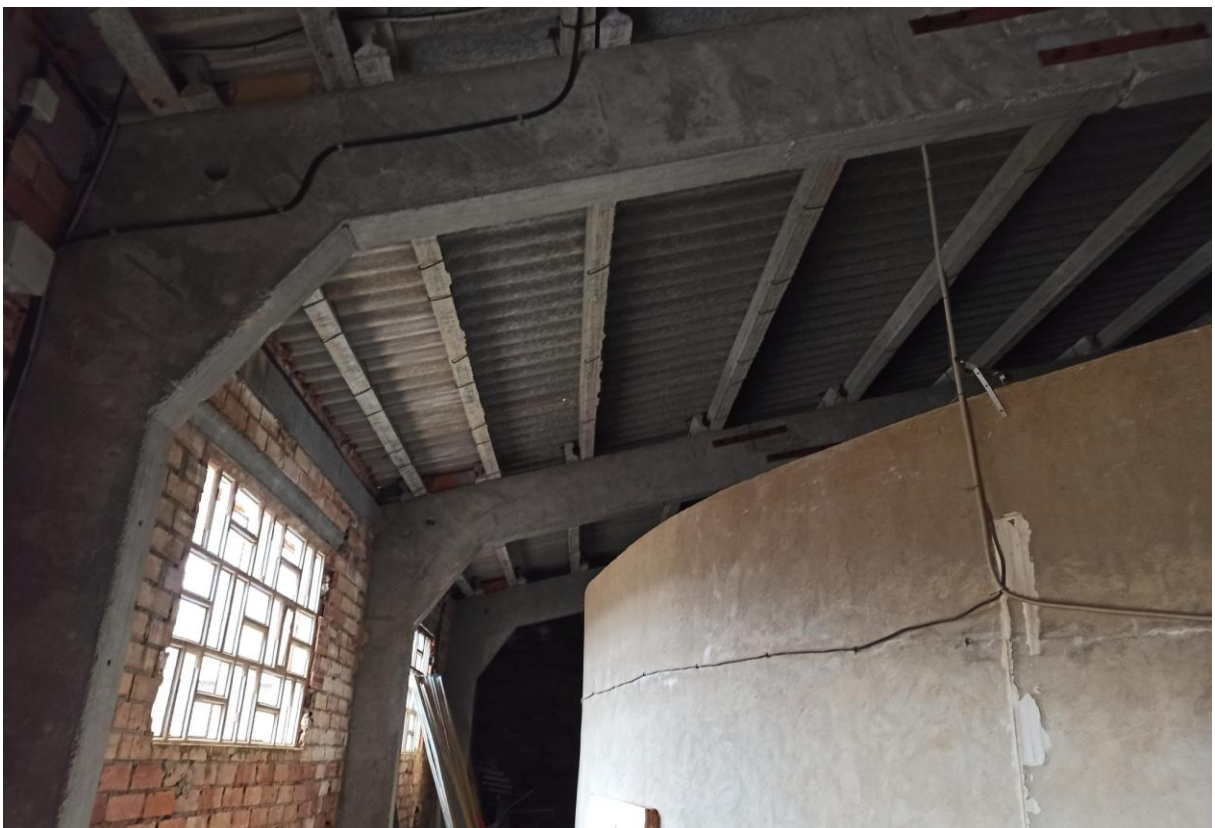
Imatge 4 Interior Dipòsit d'aigua
