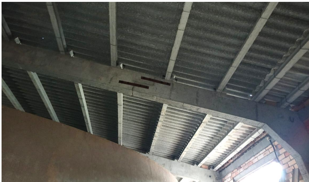
Imatge 9 Vista de l'estructura i la coberta del dipòsit d'aigua.
