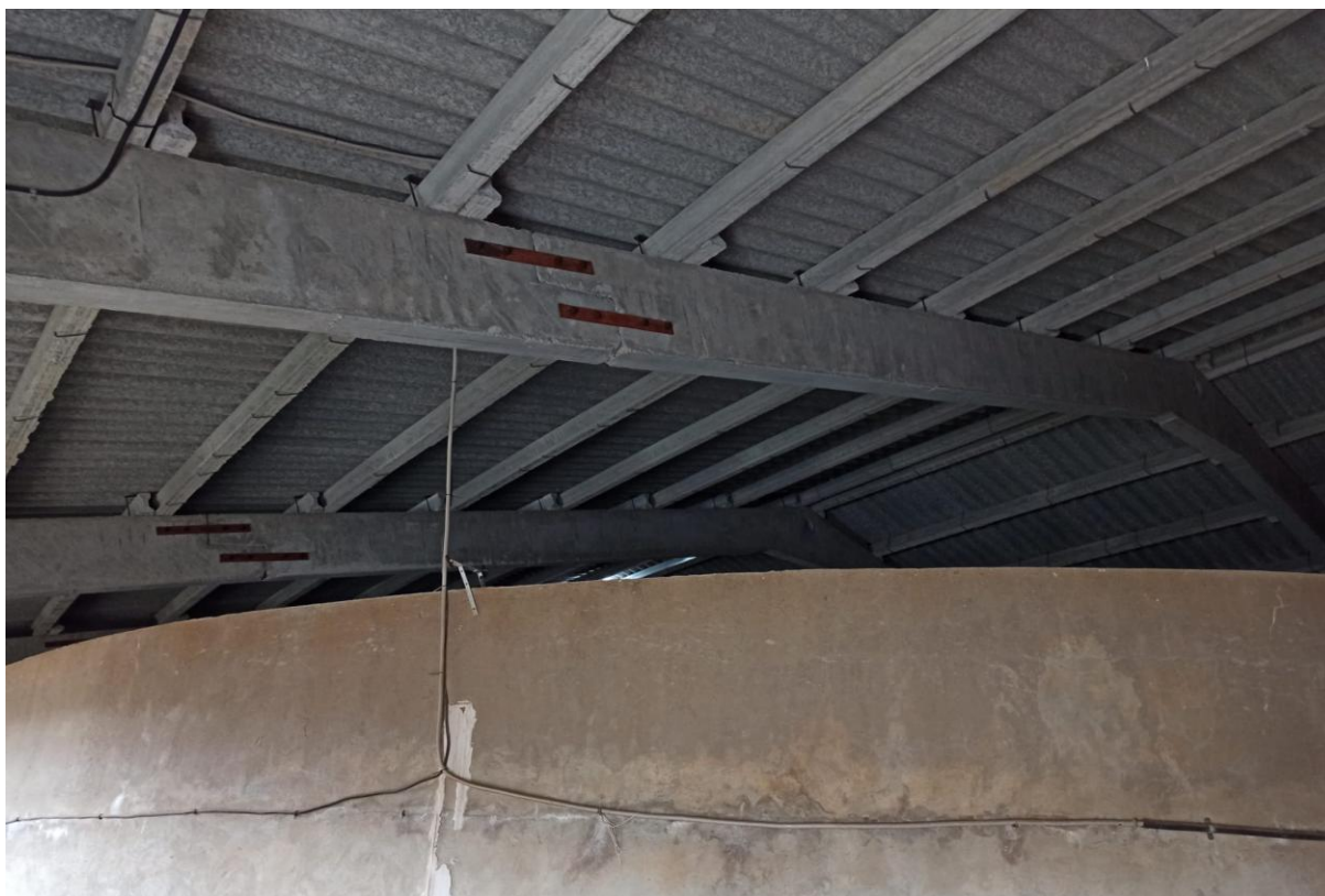
Imatge 2 Interior Dipòsit d'aigua
