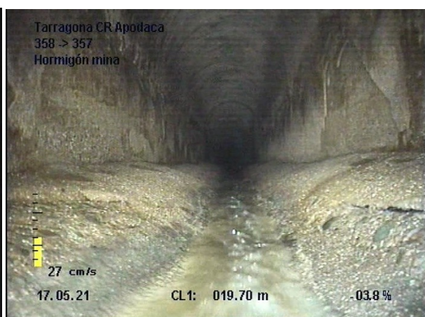
Foto 4. Inflats del recobriment i trencament.
