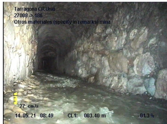
Foto 22. Solera amb pedres i altres elements
