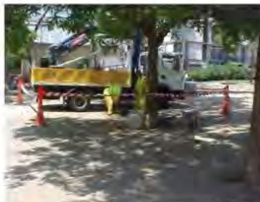
Delimitació amb cons i cinta de balisament
