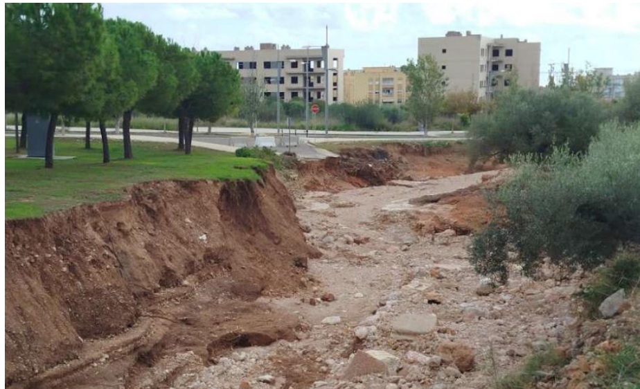
Creuament del barranc de l'Aiguassera al seu pas per la població de La Ràpita.
