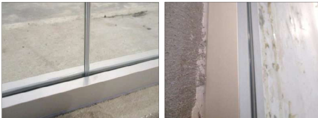
Imágenes 7 y 8 Detalles del cerramiento finalizado
