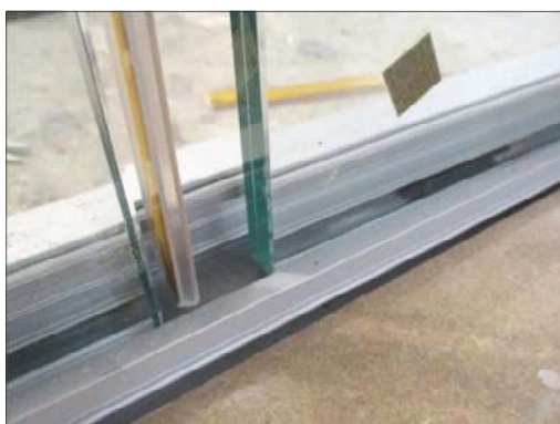
Imágenes 5 y 6 Instalación de los vidrios en el sistema de soporte
