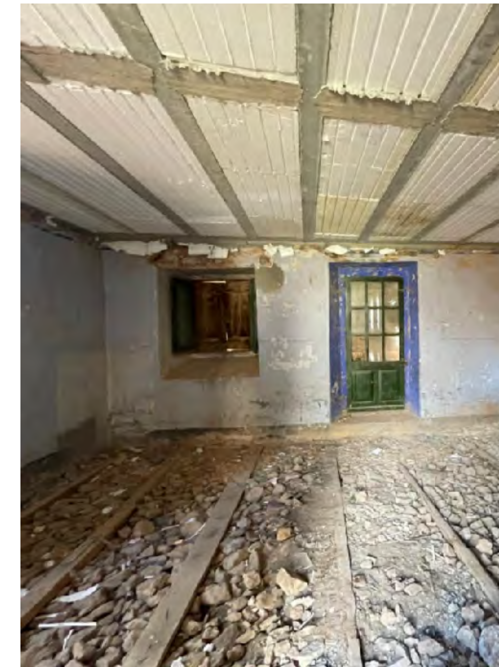
Interior local, al fons accés a l'espai exterior
