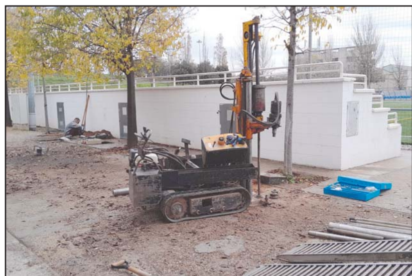
Fotografia 1. Vista de l'emplaçament de la màquina per a la realització del sondeig a rotació amb bateria continua S-1.
