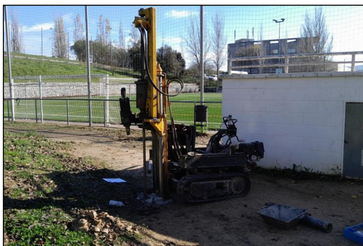
Fotografia 6. Vista de la màquina utilitzada per a la realització del sondeig a rotació S-1.
