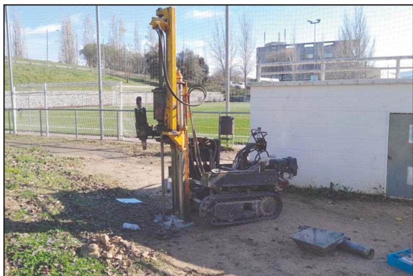
Fotografia 1. Vista de l'emplaçament de la màquina per a la realització del sondeig a rotació amb bateria continua S-2.
