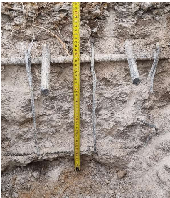
Cala de la part volada del fonament
