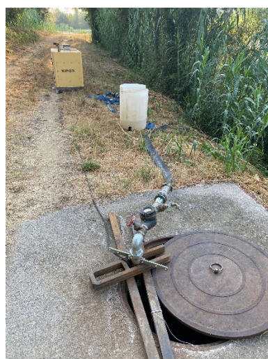
Figura 4. Proves de cabals del pou existent
