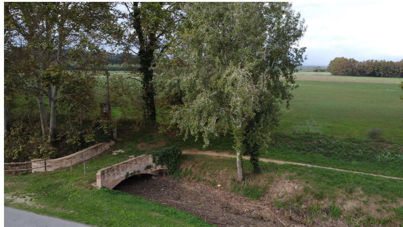
Figura 5. Punt de connexió i entrada a Estany de la Vila
