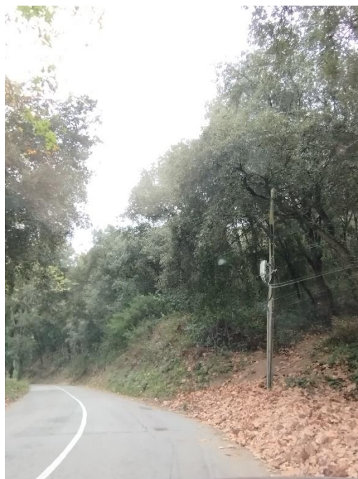
Fotografia 15: Detall servei existent aeri de telefonia
