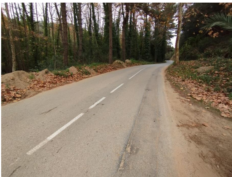
Fotografia 10: Vista general de la carretera i rasa amb serveis
