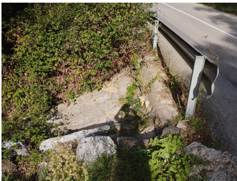
Fotografia 8: Vista del primer creuament (aigües amunt) de la riera de Sallent
