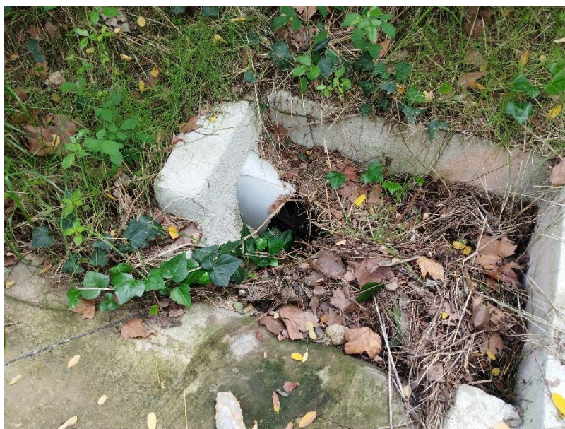
Fotografia 2: Detall de la sortida a medi de l'aigua depurada
