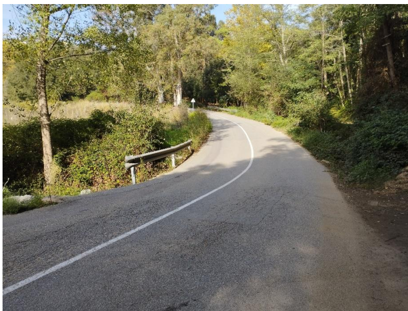
Fotografia 9: Vista del primer creuament (aigües amunt) de la riera de Sallent
