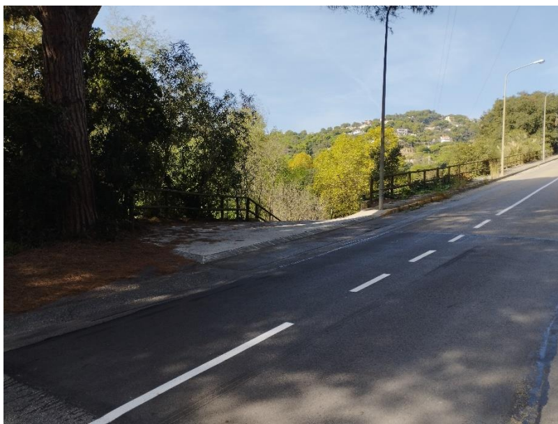
Fotografia 5: Vista general del carrer del Romaní i de l'accés a la EDAR
