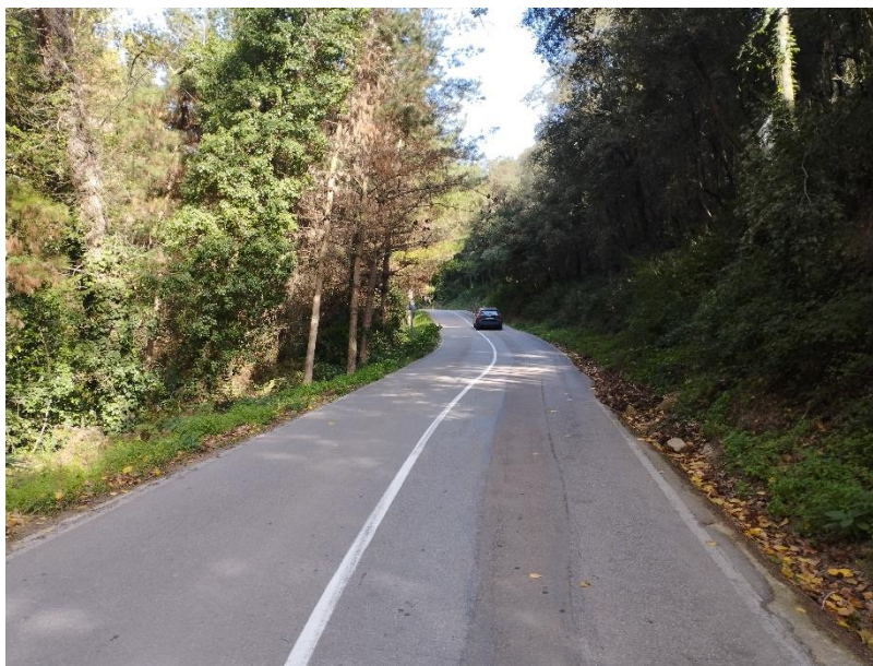
Fotografia 11: Vista general de la carretera i rasa amb serveis
