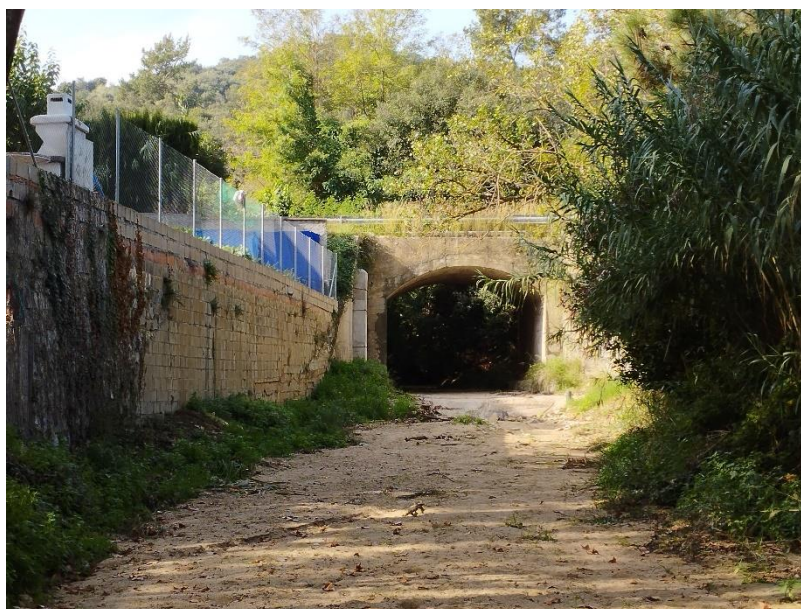
Fotografia 22: Pont de la crta.BV-5128 sobre la Riera de Sallent (vista des de de aigües avall)
