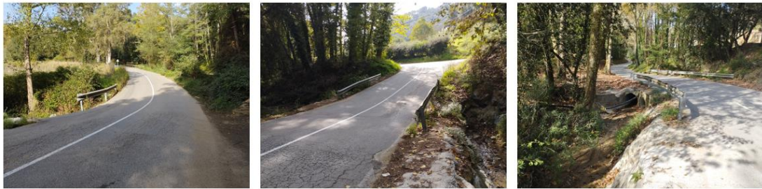
Fotografia 2: Vista dels tres creuament de la Riera de Sallent amb la carretera d'accés a Can Palau
