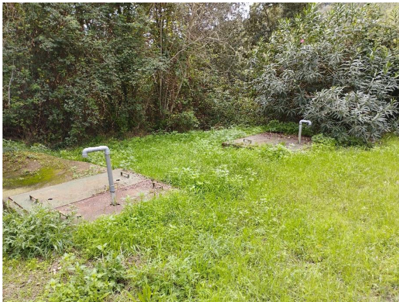
Fotografia 1: Vista estat de la depuradora d'aigües residuals existent
