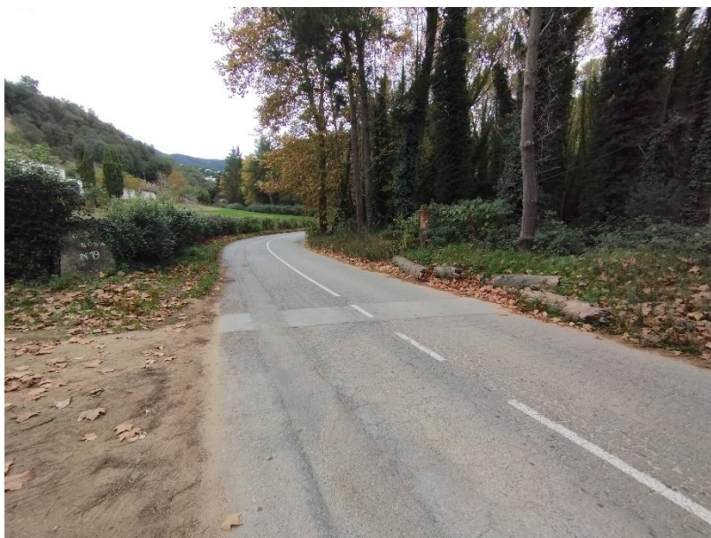
Fotografia 16: Vista general de la carretera, accés a finca i rasa de serveis
