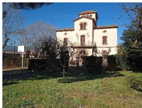
Fig 13. Pati de la Casa de les Monges
