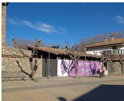
Fig 4. Façana de l'Annex Casal de Gent Gran
