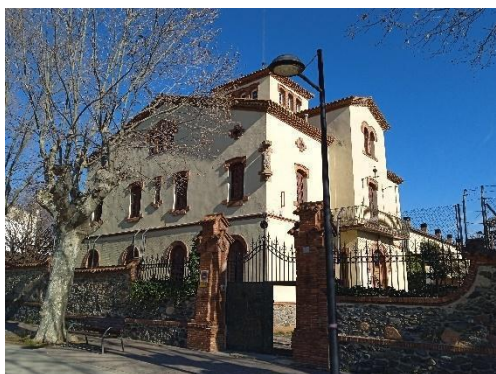
Fig 12. Façana de la Casa de les Monges
