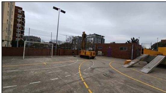
MÀQUINA REALITZANT EL SONDEIG S-1.
