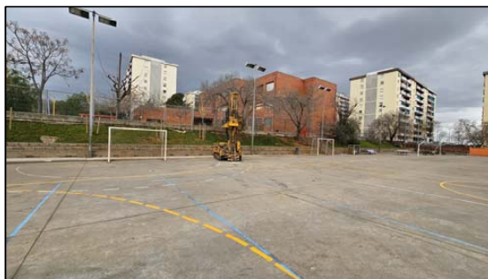
MÀQUINA REALITZANT EL PENETRÓMETRE P-1.
