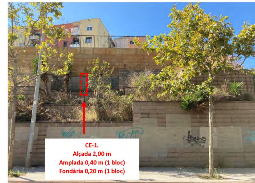
CE-1. Cala frontal fins cara inferior de sabata del mur de formigó armat.
