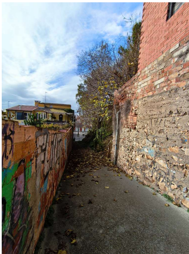
Vista passatge amb façana posterior
